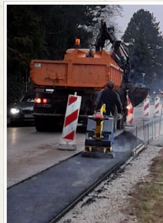
Straßensanierung in Rothenberg
